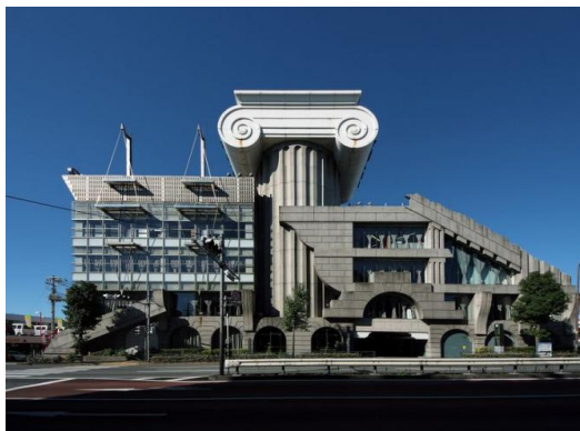
Рисунок 1. Здание «M2». Архитектор Кенго Кума, г.Токио, Япония
